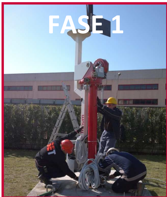
Sollevamento e posizionamento
